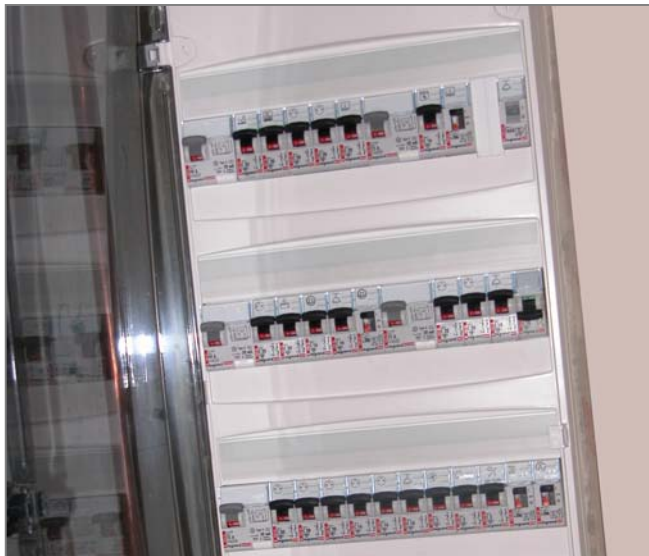
Installation / Rénovation Mise au normes
